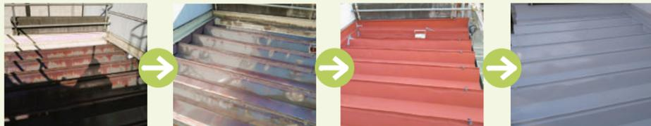
赤錆だらけの屋根の赤錆除去を行った後、錆止め、塗装を行い作業完了となります。悪天候の際は作業がストップしてしまう為、作業は迅速丁寧を心がけています。
