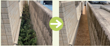
雑草で地面が見えなかった、家と塀の間に雑草対策としてウッドチップを敷きました。
